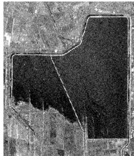
Sentinel – 1, 20 мая 2015 г. Западная часть плотины южнее прорыва заполнена
